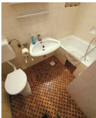
Das in die Jahre gekommene Bad vor der Sanierung
