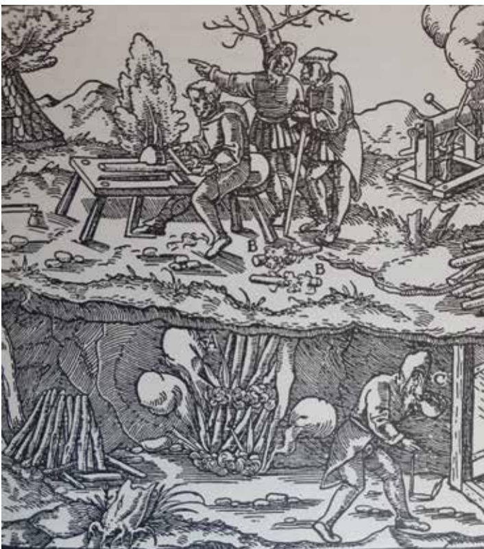
Abb. 3. Feuersetzen zum Lockern des Erzes in Stollen, Strecken und Abbauen Holzschnitt aus Georg AGRICOLAS „De re metallica“ (1556)
