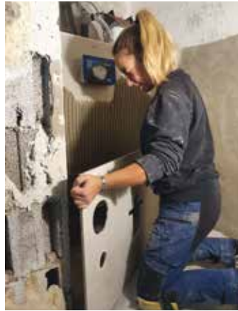
Victoria beim Verlegen von Großformatfliesen in einem Bad „Jede Baustelle ist anders und es gibt täglich neue Herausforderungen – das gefällt mir.“
